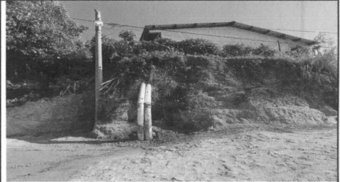
Foto 2: Sustitución de tubería de aguas plubiales
